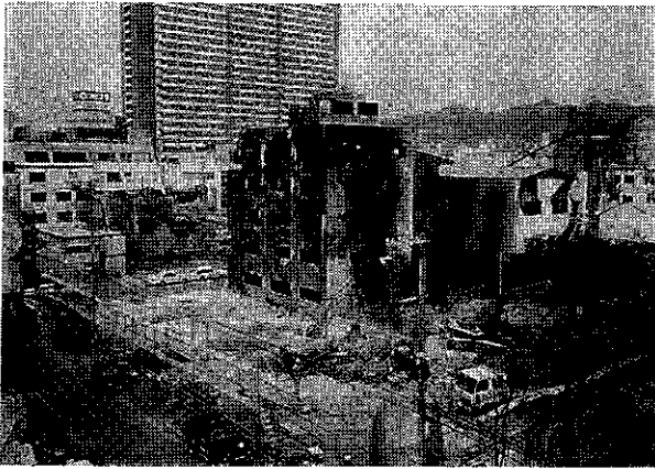
写真1 復興へ向けて建物解体撤去
