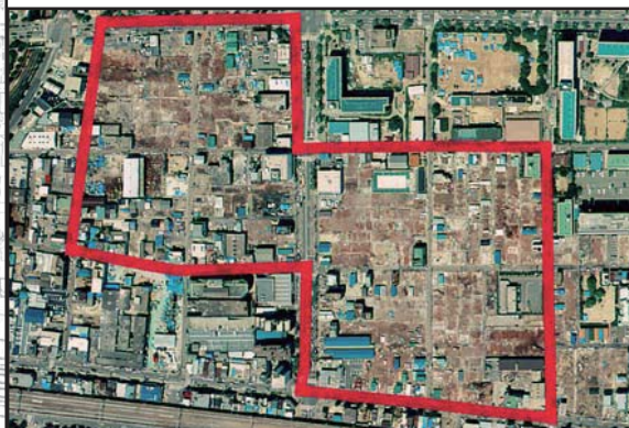
震災後 平成7年5月
