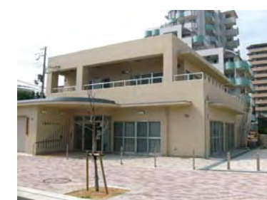
公園脇に整備された千歳地区センター
