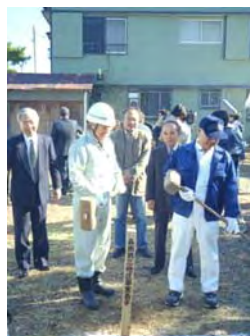
杭打ち式／森南第三地区
