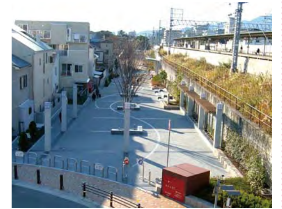
広場東側より
