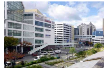
弁天町交差点デッキ改良
