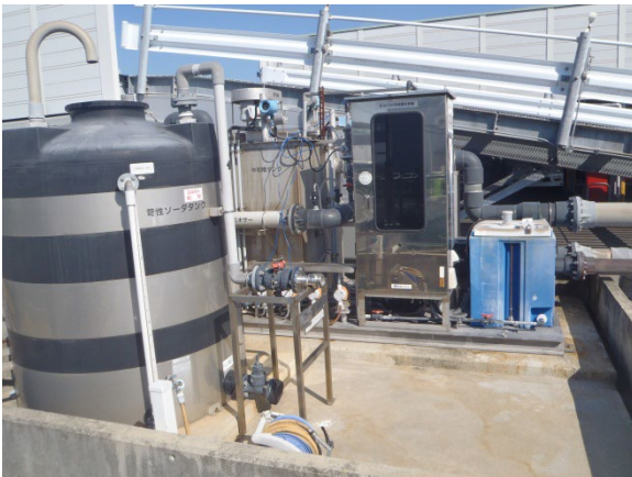
中和処理施設全体
