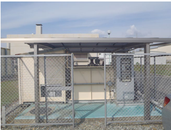
中和処理施設全体
