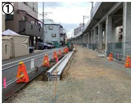
① 魚崎地区側道工事中
