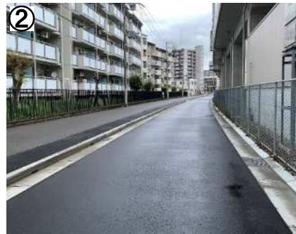
② 青木幹線西側車道部暫定供用中
