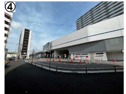
④ 深江駅北側広場暫定供用中
