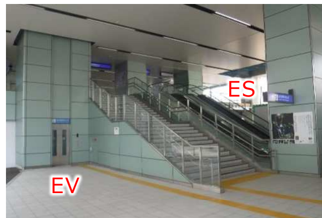
駅舎出入口 (整備後)
