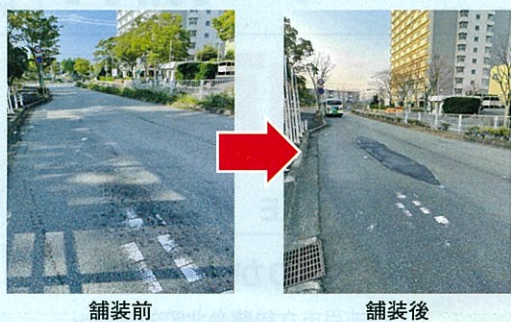
舗装前 舗装後
