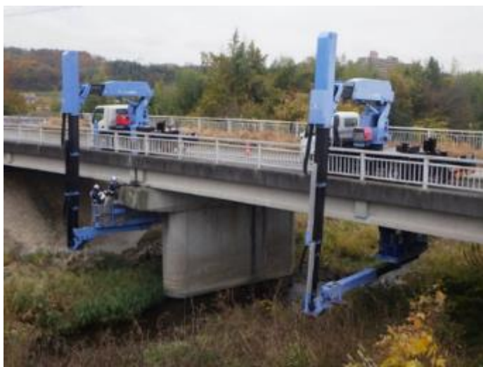
道路橋梁の法定点検例 （橋梁点検車を用いた近接目視点検）
