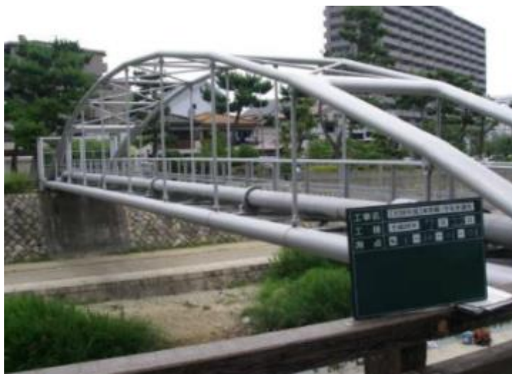
直営作業による点検例 （目視点検）
