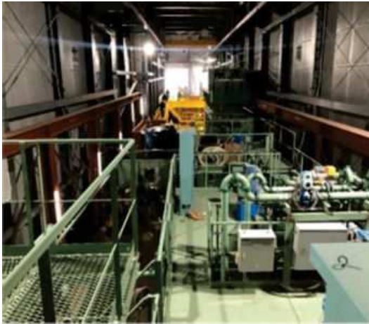
【シールド発進基地(防音ハウス内)】
