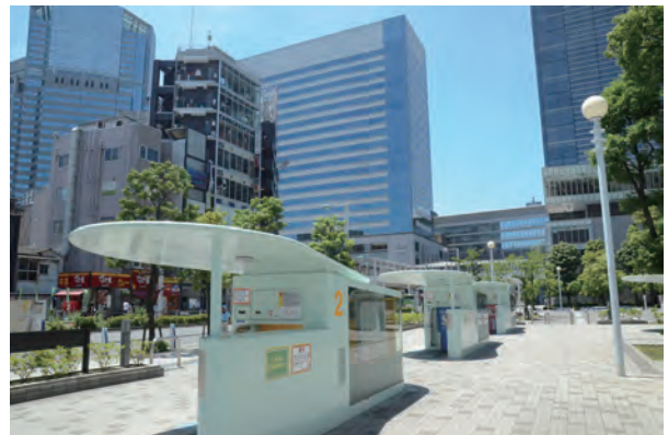
○需要に応じた規模と景観への配慮を兼ねた駐輪場の整備。（東京都港区：地下機械式駐輪場）
