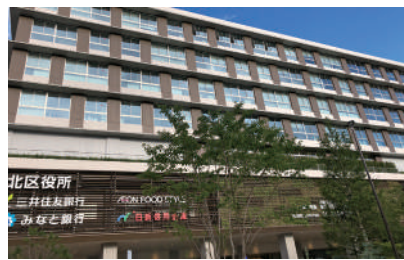
▶ 再整備された北区役所。この鈴蘭台駅の 近くに北図書館も移設し、利便性の向上を！
