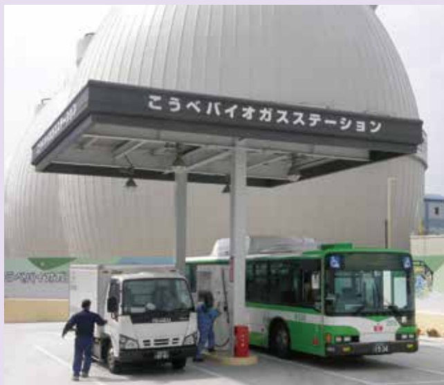
こうべバイオガスステーション (東灘処理場)
