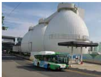
こうべバイオガスステーション (自動車燃料)
