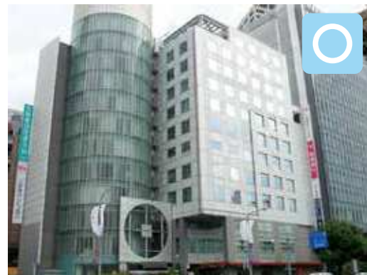
窓は窓としての機能を持たせることが、建物として健全です。
