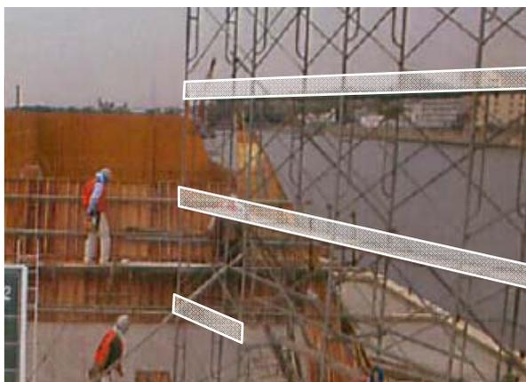
交さ筋かい下部のすき間からの墜落を防止するため、「幅木」等を加えて設置しなければならない
