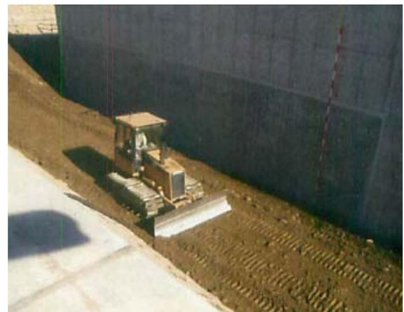
2段目以降の施工状況 (ブルドーザ使用)
