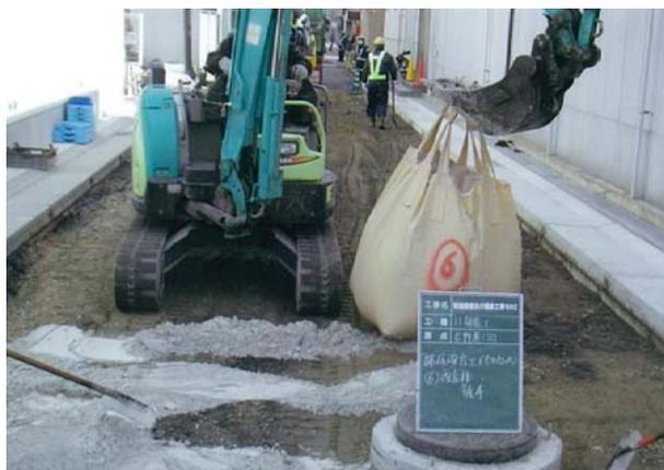
パワー・ショベルの爪に標準荷重を超える大型土のうを引っ掛けて作業を行い、横転する恐れがあった
