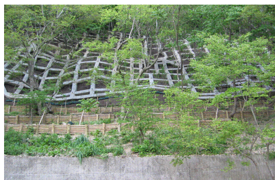
（自然環境に配慮した斜面对策）
