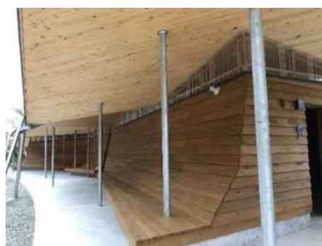
発生材の利活用（六甲最高峰トイレ）
