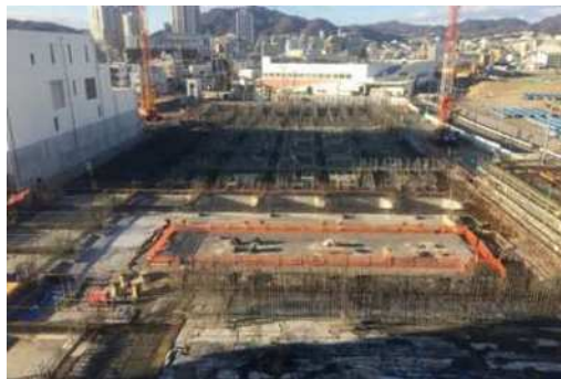
西部処理場北系整備
