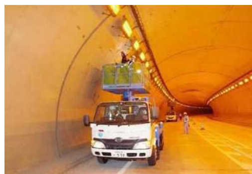
トンネル点検
