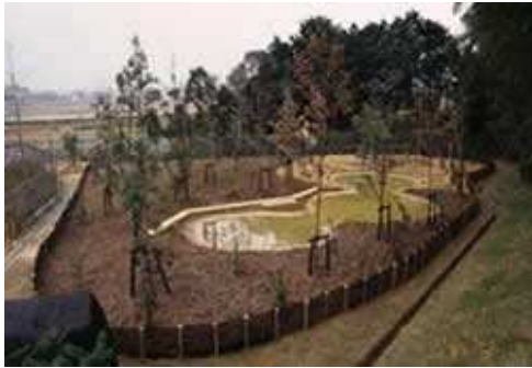
ビオトープ施設全体
