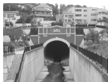
房王寺橋から東方向 湊川隧道を望む
