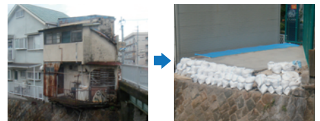
老朽危険家屋の解体 (行政代執行)
