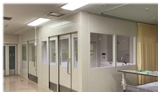
写真52 感染対策工事を行った血液透析室
