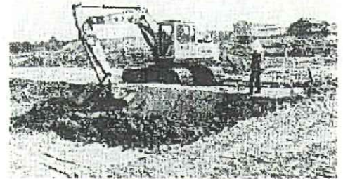
大規模な圃場整備工事
