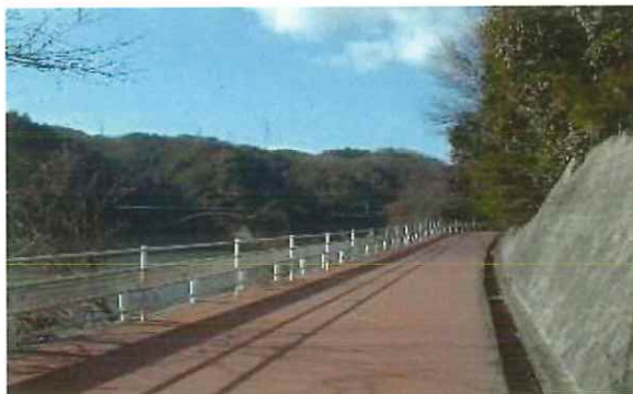
図 2-29 カラー舗装された自転車道（つくはら湖）
