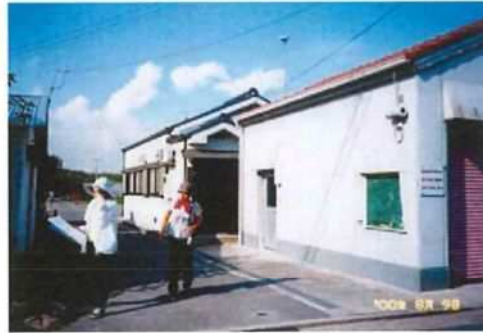
写真3-5 手前は消防機具庫、奥は集会所
