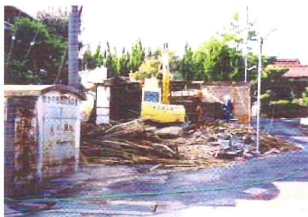
旧公会堂の解体
