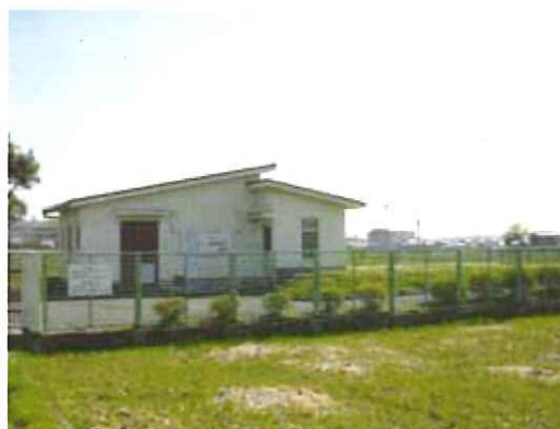
集落排水処理施設
