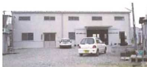
菅野土地改良区施設
